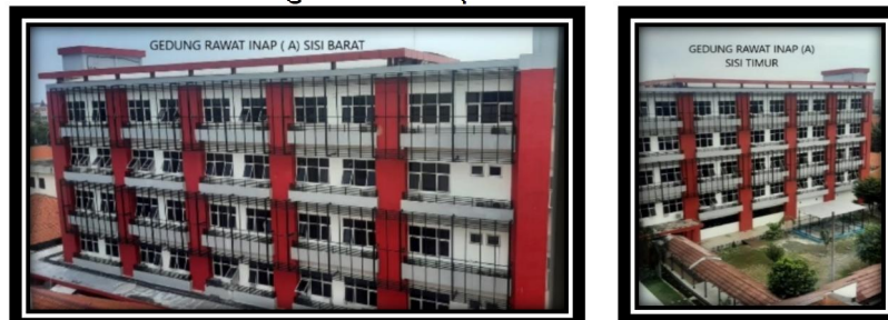
Gambar 2.5 Gedung Rawat Inap A RSUD Brebes
