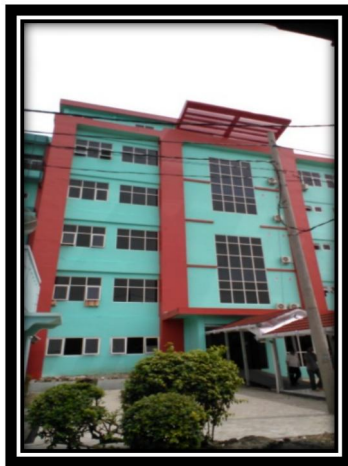
HASIL PELAKSANAAN PEMBANGUNAN GEDUNG RS TAHAP I TAHUN 2017
