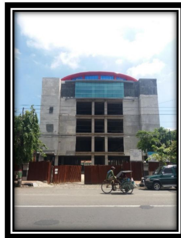
HASIL PELAKSANAAN PEMBANGUNAN GEDUNG RS TAHAP II TAHUN 2018
